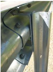
Stützbügel 4.00 Profil A bzw. 4.10 Profil B
